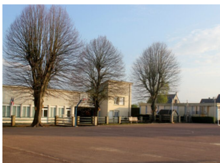
Ecole primaire des 2 fontaines, Fontenay-le-pesnel
